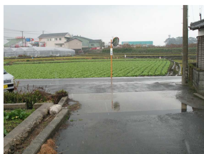
カーブミラー設置
